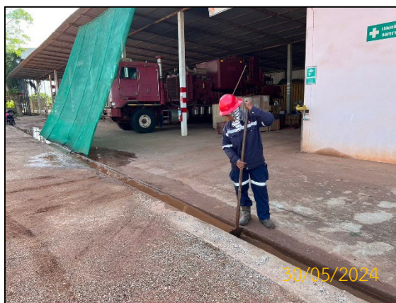
ภาพที่ 2.5-11 ทำความสะอาดรางระบายน้ำ
