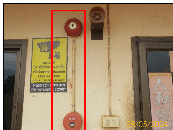
ภาพที่ 2.5-21 อุปกรณ์ป้องกันอัคคีภัย และสัญญาณเตือนอัคคีภัย
