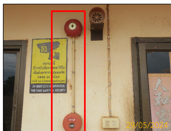
ภาพที่ 2.6-6 อุปกรณ์ป้องกันอัคคีภัย และสัญญาณเตือนอัคคีภัย
