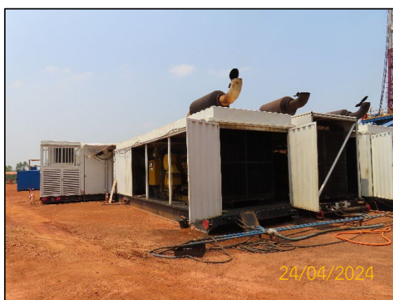
ภาพที่ 2.3-6 การติดตั้งเครื่องกำเนิดไฟฟ้าในตู้คอนเทนเนอร์
