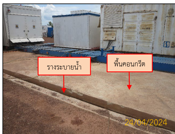
ภาพที่ 2.3-7 พื้นคอนกรีตและรางระบายน้ำ
